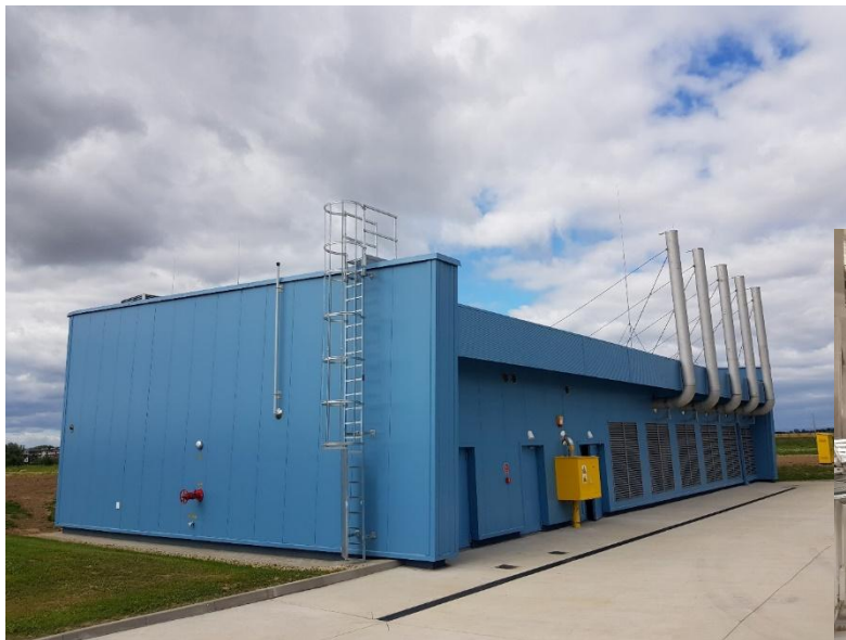
Elektrownia rezerwowa (dwupaliwowa Diesel / gaz ziemny) 5 x 1 MW
