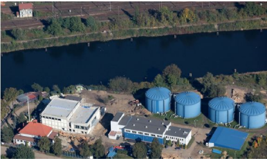
stacje uzdatniania wody
